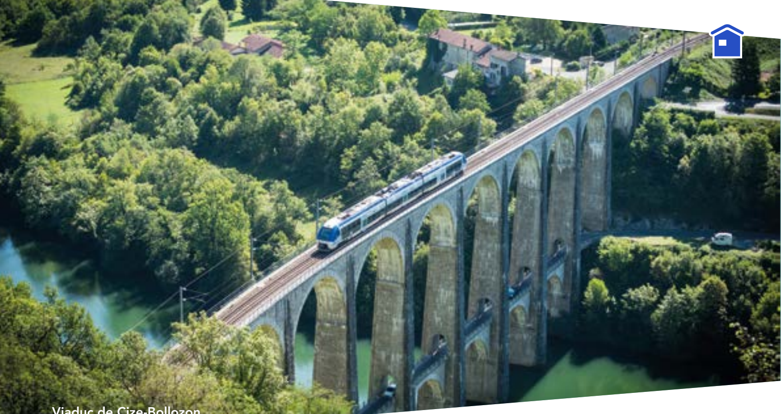
Viaduc de Cize-Bollozon
