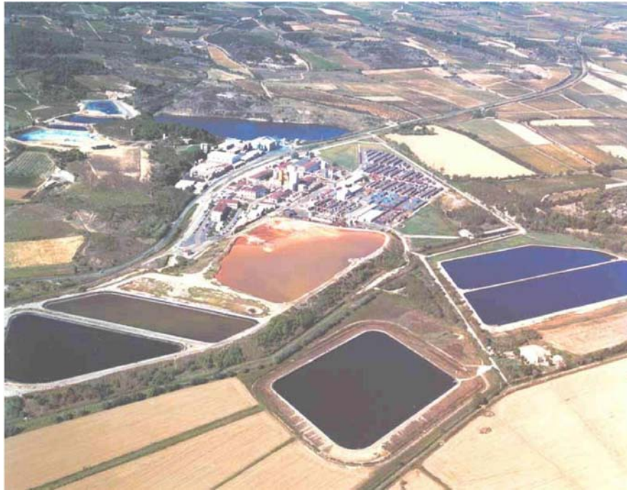
Vue aérienne de l'usine COMURHEX avant rupture de la digue B2 / Doc COMURHEX présenté au CLIC du 25 novembre 2005
