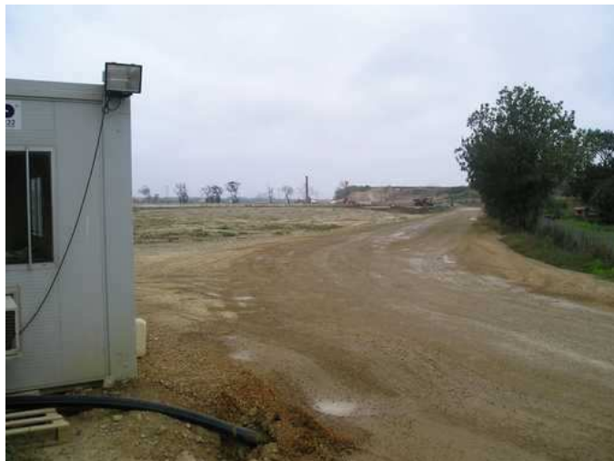
Travaux de réparation des digues des bassins B1 et B2 devant la propriété C / 22 septembre 2006
