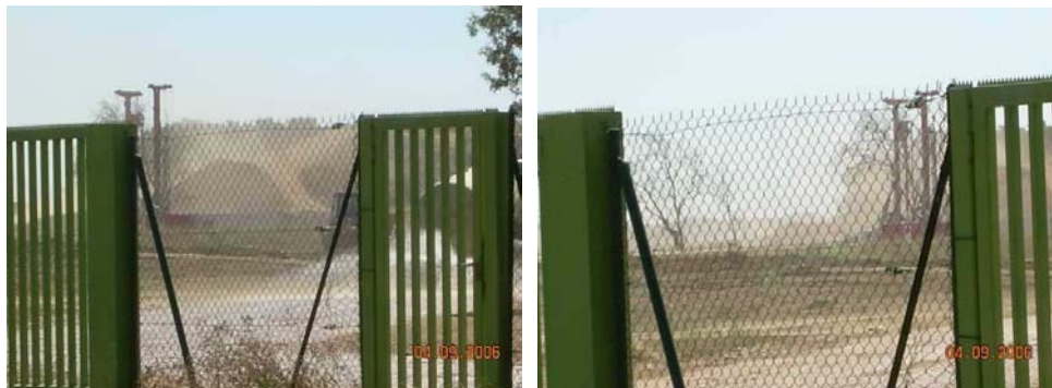
Photographies prises par un riverain le 9 septembre 2006 depuis son terrain situé en bordure du chantier (nuages de poussière).
