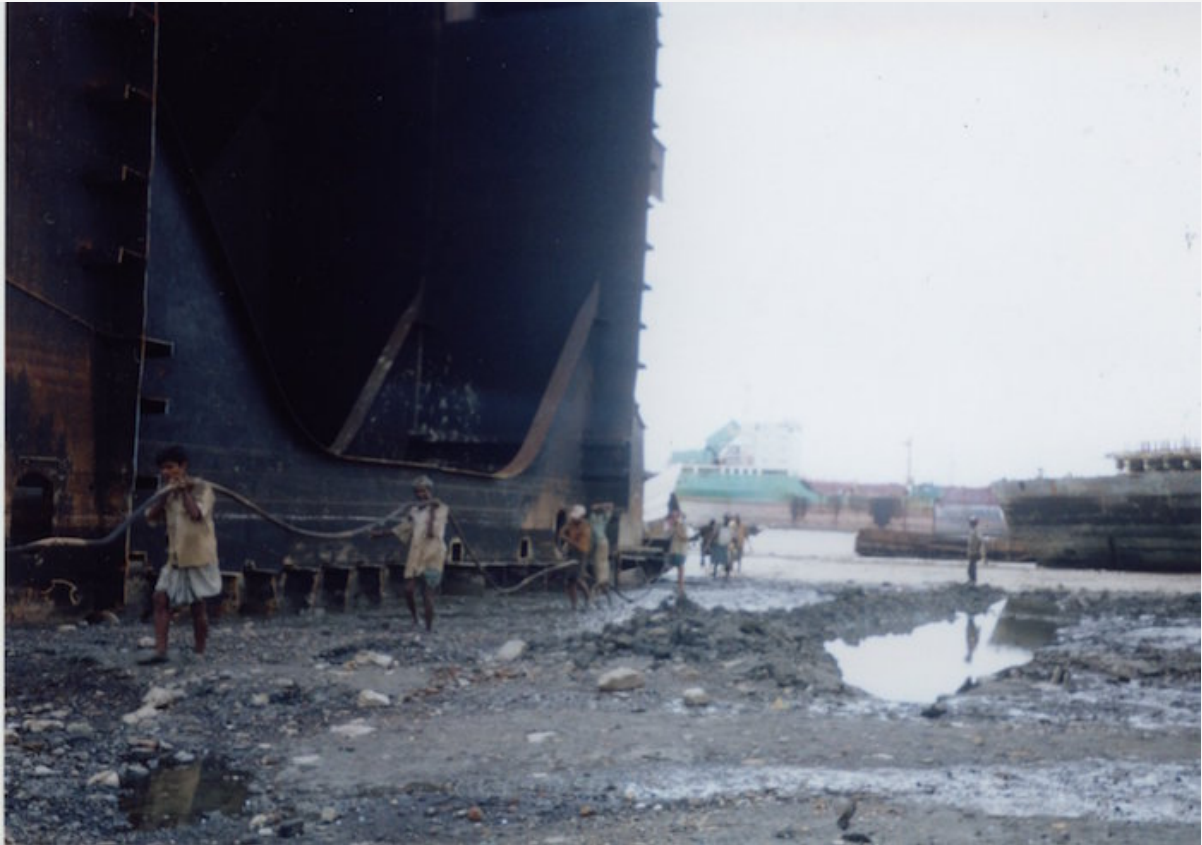
La démolition d'un vraquier à Chittagong, au Bangladesh, en 2006.
