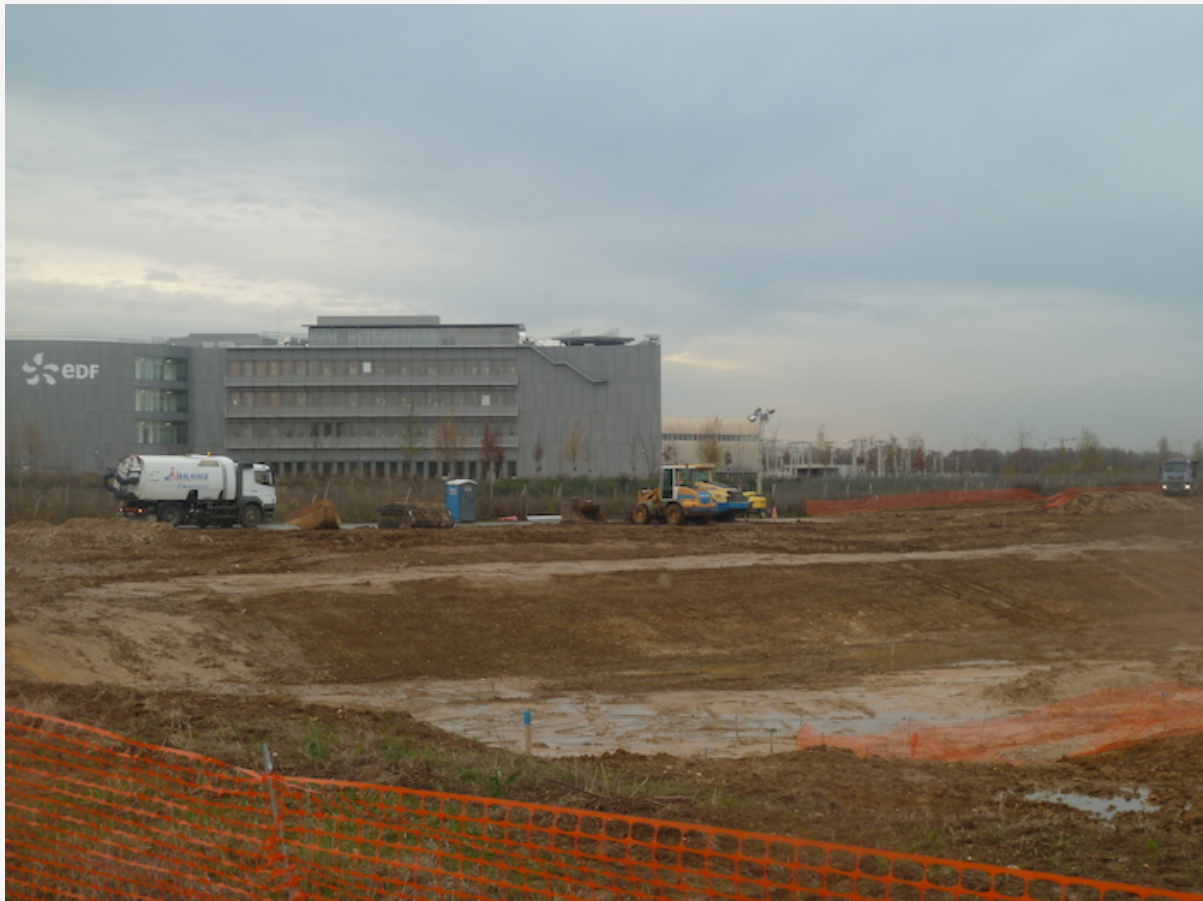
En face du bâtiment EDF, sur la zone d'aménagement concerté dite de Polytechnique, deux bassins de rétention sont en construction.
