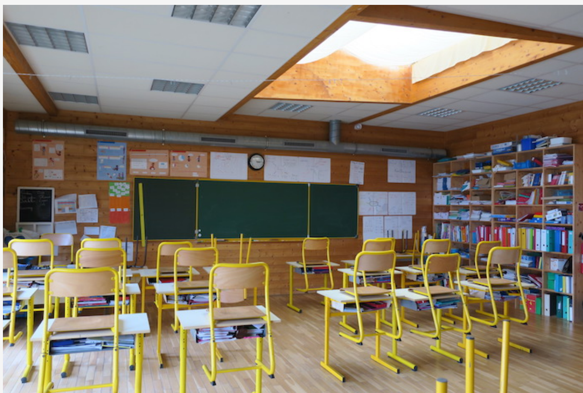
A Langouët, l'école, construite en 2003 selon la norme HQE, possède des puits de lumière rendant moins utile l'éclairage électrique.
