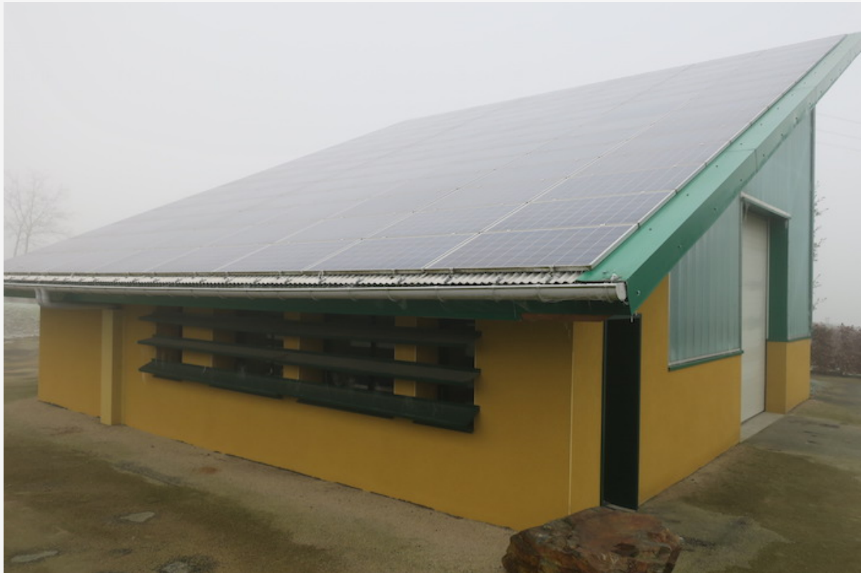
L'atelier municipal a un toit solaire
