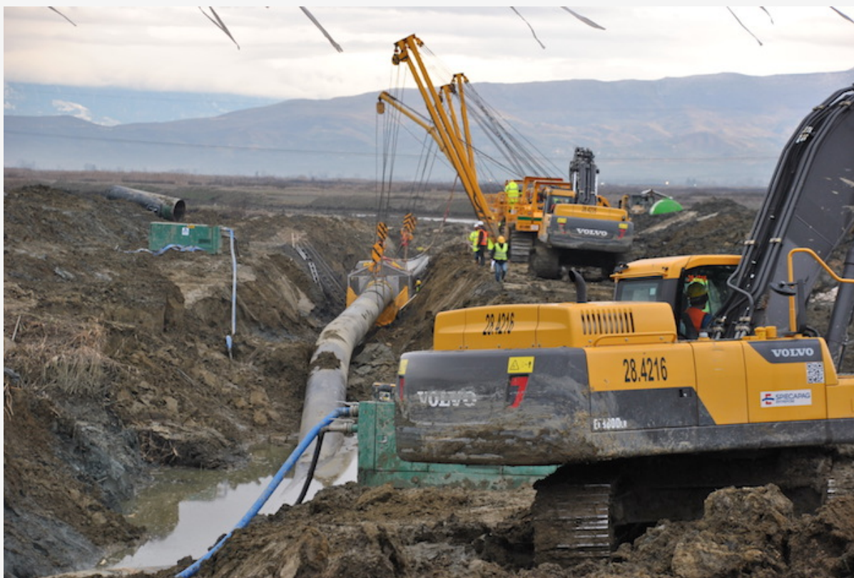
Les travaux du TAP sont sous la supervision de Spiecapag, une filiale de Vinci construction.
