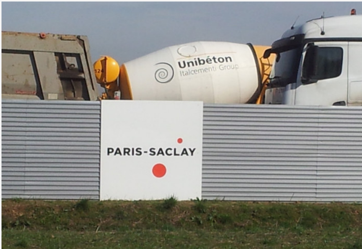
Sur le plateau de Saclay, le béton coule...
