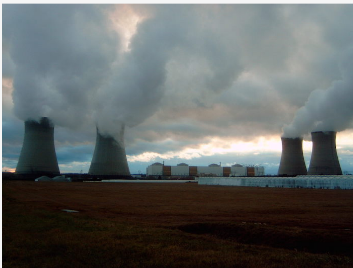
La centrale nucléaire de Dampierre (Loiret).
