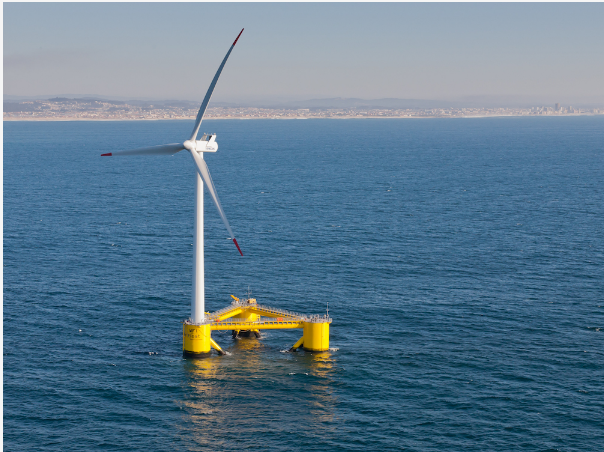
Une éolienne «flottante» au large du Portugal.
