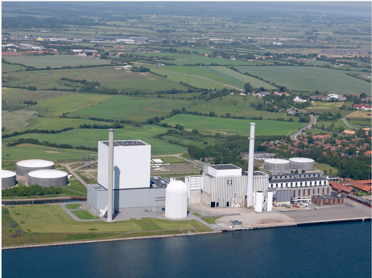
La centrale à biomasse danoise de Skærbæk.
