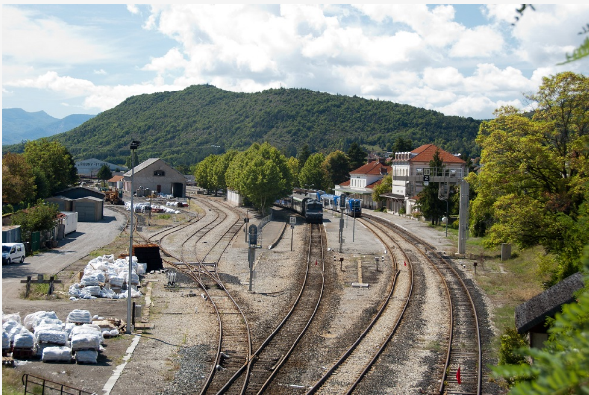
Les lignes se croisent dans l'ancienne cité cheminote de Veynes (Hautes-Alpes).
