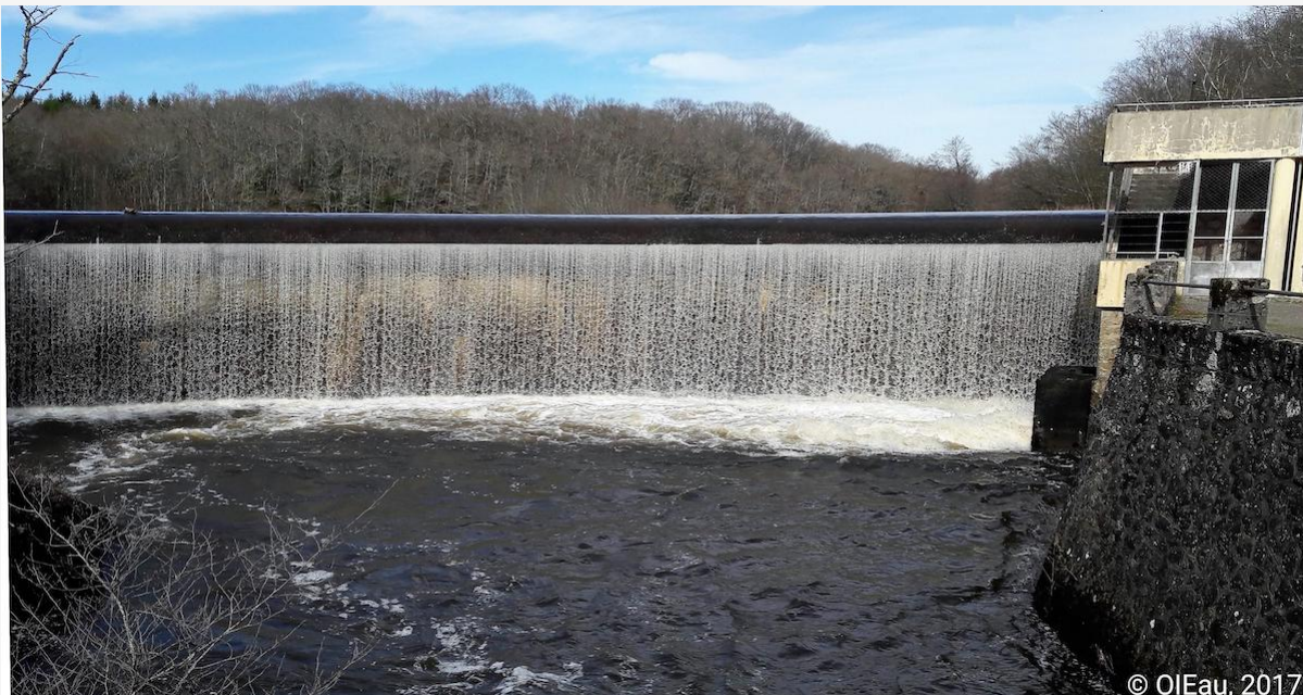
Barrage et station de pompage du Gué-Giraud, à Saint-Junien (Haute-Vienne).
