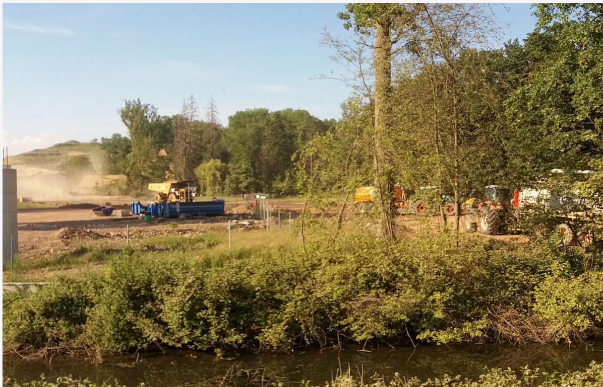
Sur le chantier du «grand contournement ouest» de Strasbourg.
