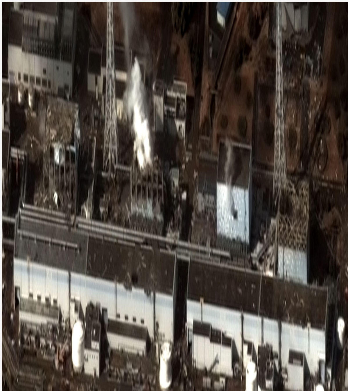
Image satellite des installations de la centrale de Fukushima Daiichi après l'accident nucléaire (Digital Globe)
