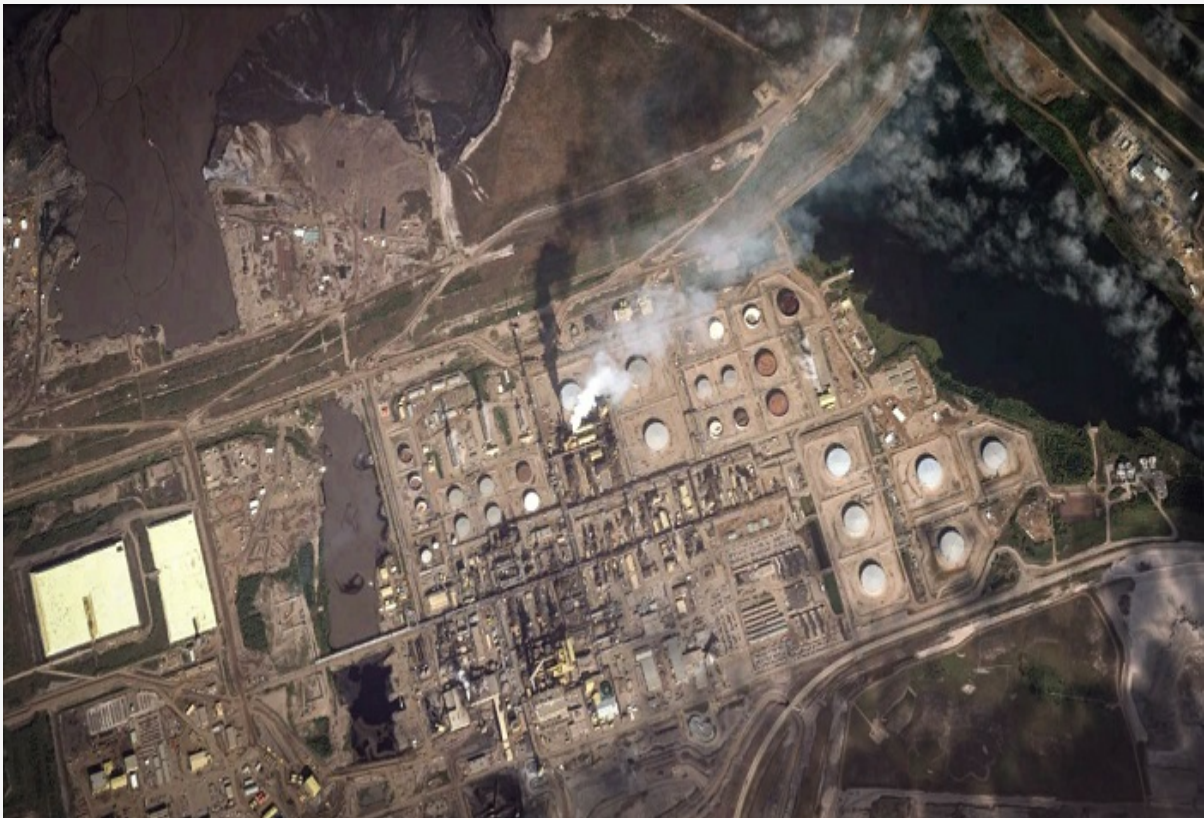
Vue aérienne d'un chantier pétrolier au nord de Fort McMurray. Source : Google Earth
