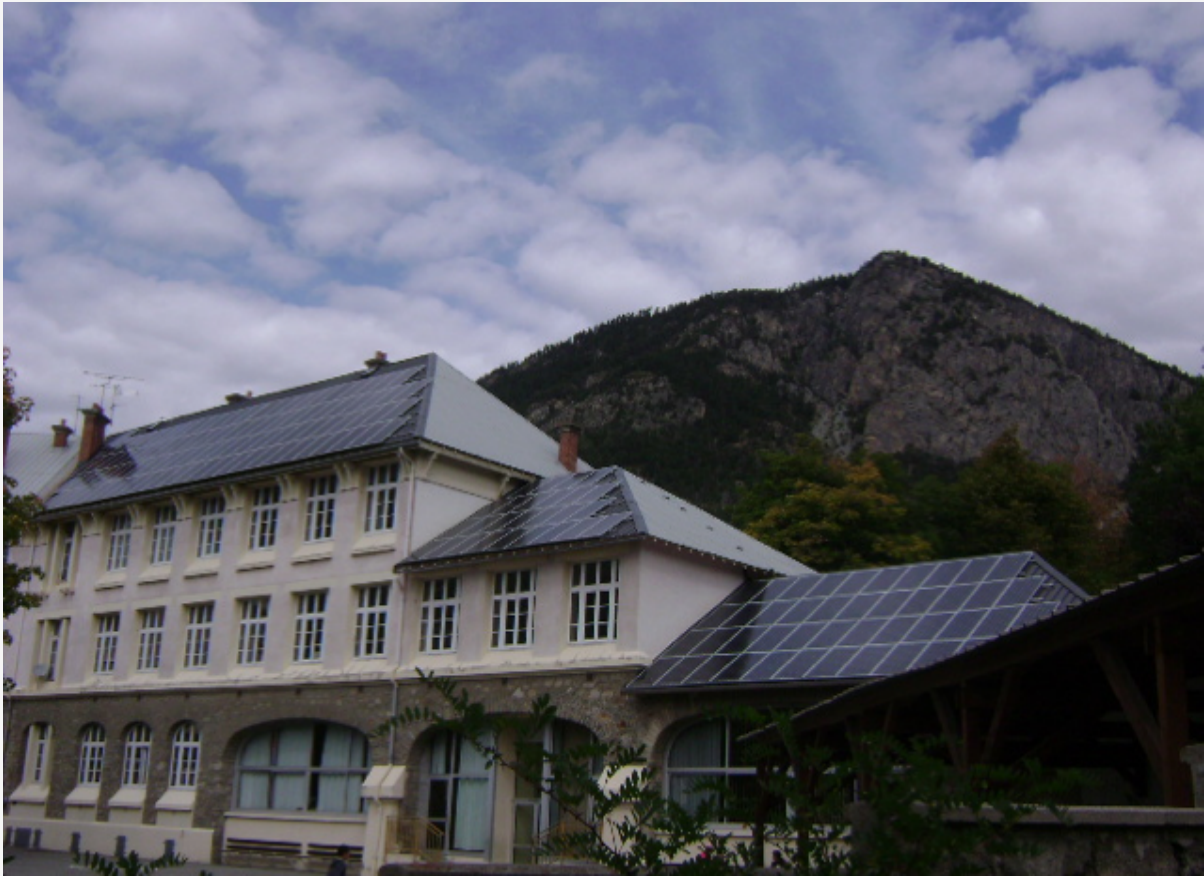
Toiture photovoltaïque de l'école de Mi-chaussée à Briançon
