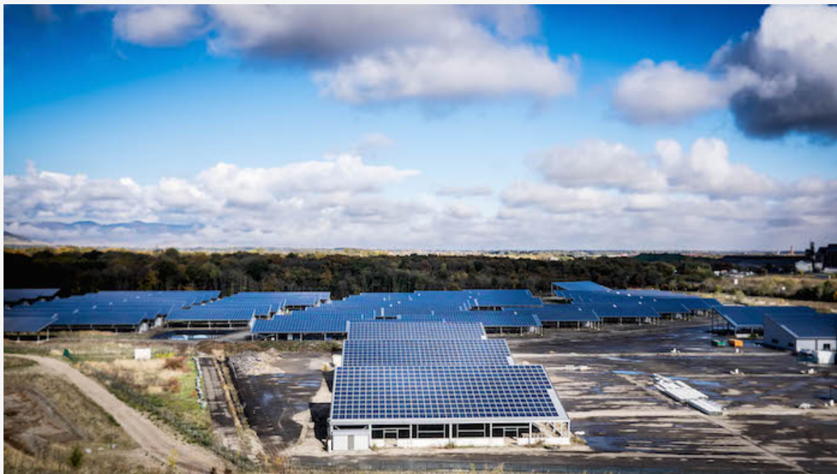
La commune d'Ungersheim a construit la plus grande centrale photovoltaïque d'Alsace, avec quarante mille m 2 de panneaux.
