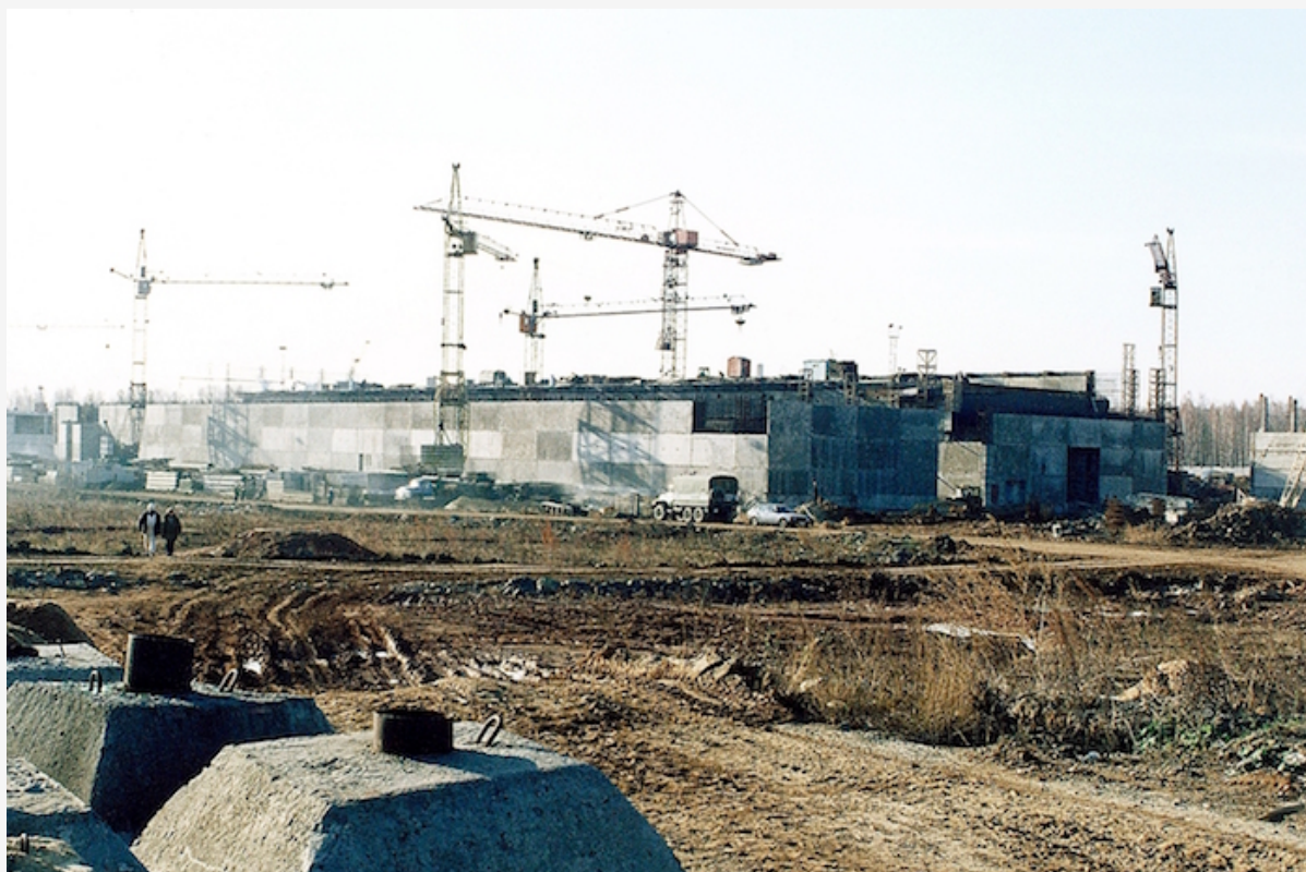
Construction du centre de stockage de déchets nucléaires de Maïak (date inconnue).
